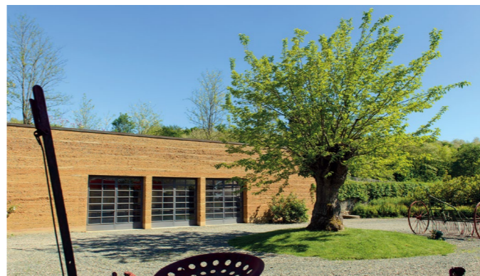
La cantina La Raia con il suo muro in pisé (terra cruda) realizzato da Martin Rauch (© C. Dutton)
